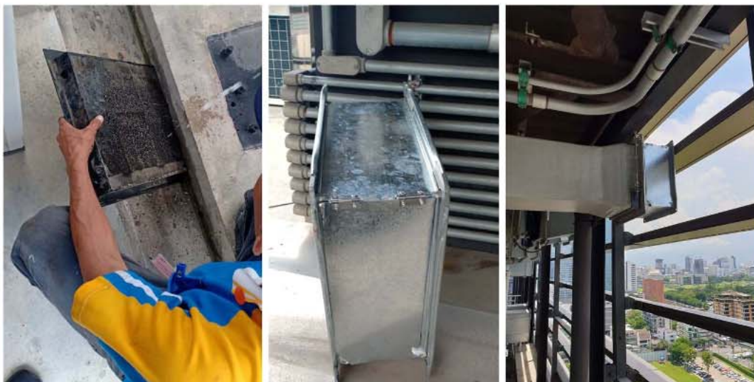
ภาพที่ 2-35 ติดตั้ง ถังกรองบรรจุ Activated Carbon และแผ่น Filter สำหรับการบำบัด Aerosol และดูแลรักษาโดยตอนแผ่น Filter นำมาล้าง
