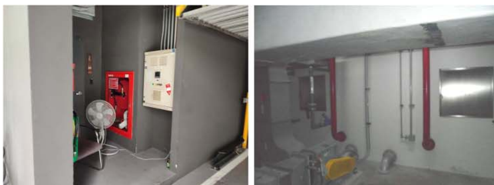
ภาพที่ 2-21 ตู้เก็บสายชนิดน้ำดับเพลิงพร้อมอุปกรณ์ และท่อเย็น
