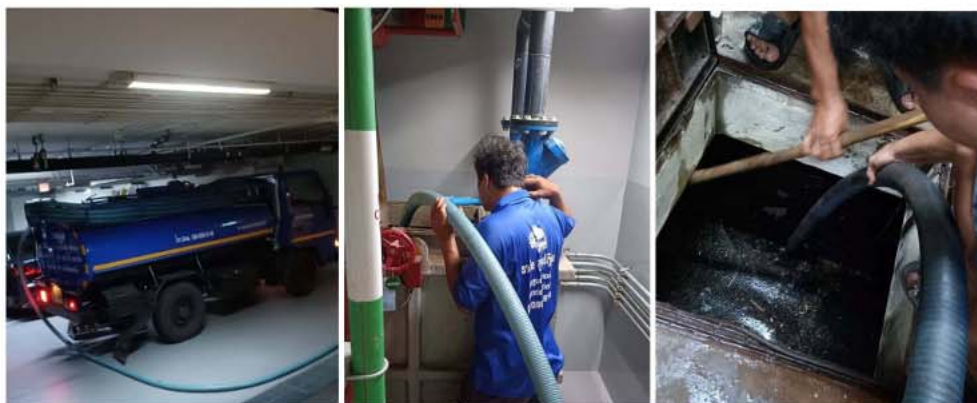
ภาพที่ 2-8 บริเวณถังบำบัดน้ำเสีย และการดูแลระบบบำบัดน้ำเสีย
