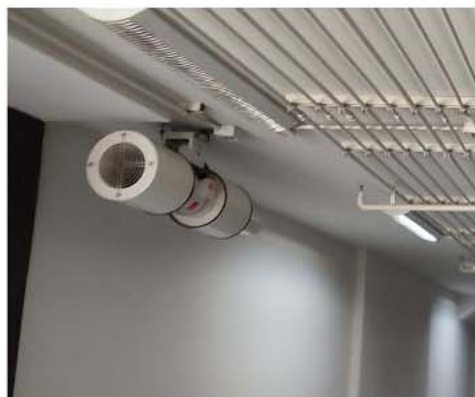
ภาพที่ 2-6 พัดลมระบายอากาศที่มีตัวกรองอากาศ
