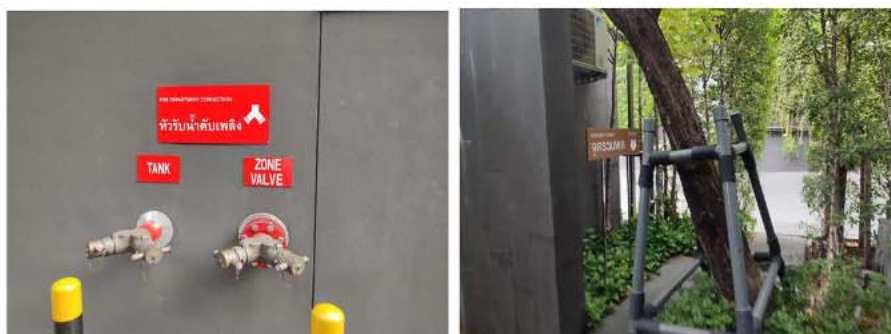
ภาพที่ 2-37 หัวรับน้ำดับเพลิงจากภายนอก และพื้นที่จุดรวมพลด้านหน้าทางเข้าออกโครงการ
